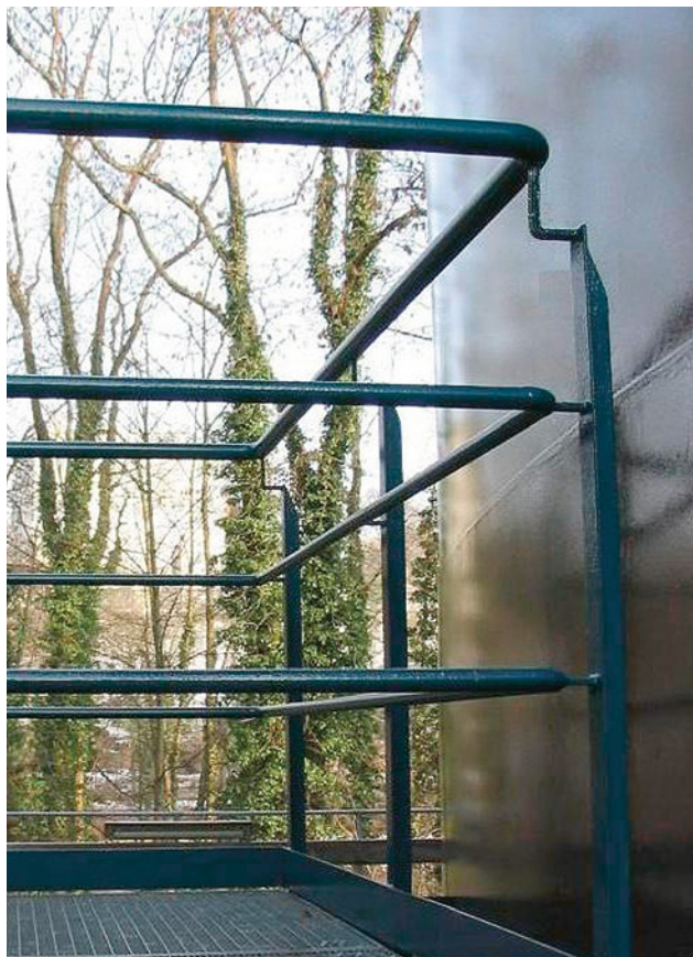
14 Garde-corps de palier avec une main courante placée à au moins 75 mm du mur.
