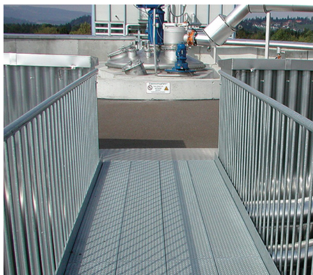
18 Garde-corps avec des barreaux verticaux. L'espace entre les barreaux ne dépasse pas 180 mm.
