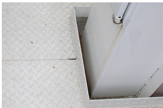
9 Plinthe au bord d'une ouverture dans le sol, dont la distance horizontale par rapport au pilier est supérieure à 20 mm.
