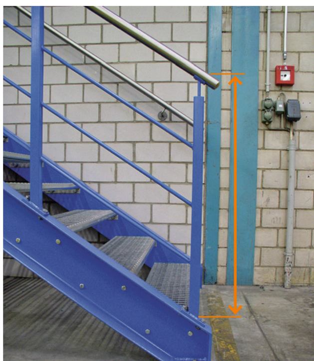
11 La hauteur du garde-corps des escaliers doit être choisie de sorte que la hauteur verticale du nez de chaque marche jusqu'au bord supérieur de la main courante soit entre 0,90m et 1,0m.
