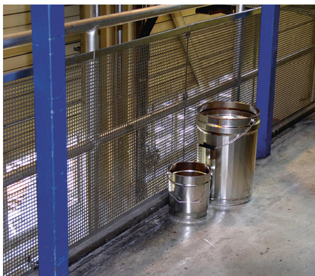
17 Le grillage ajouté sur toute la surface du garde-corps empêche efficacement la chute dans le vide de personnes ou d'objets.
