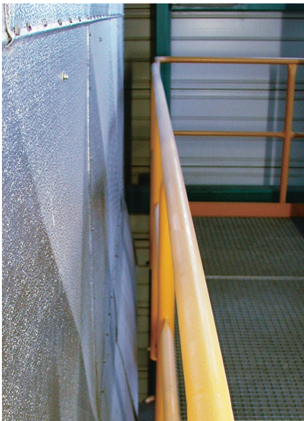
7 Garde-corps servant à sécuriser des bords donnant sur le vide à proximité de murs ou de machines. L'installation d'un garde-corps est obligatoire, car la distance entre la passerelle et l'entourage de la machine dépasse 180 mm.
