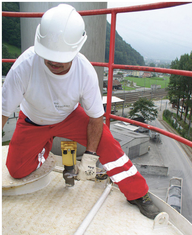
19 La plinthe d'au minimum 100mm de haut empêche qu'une personne ne glisse sous le garde-corps lors de travaux de maintenance ou que des objets ne tombent mettant ainsi des personnes en danger.
