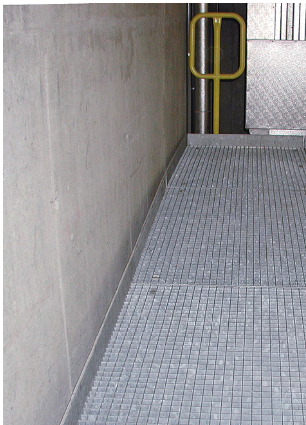
8 Plinthe servant à sécuriser des bords donnant sur le vide à proximité de murs ou de machines. L'installation d'une plinthe est obligatoire, car la distance entre la passerelle et l'entourage de la machine dépasse 20 mm. A l'arrière, où la distance est supérieure à 180 mm, un garde-corps a été installé.
