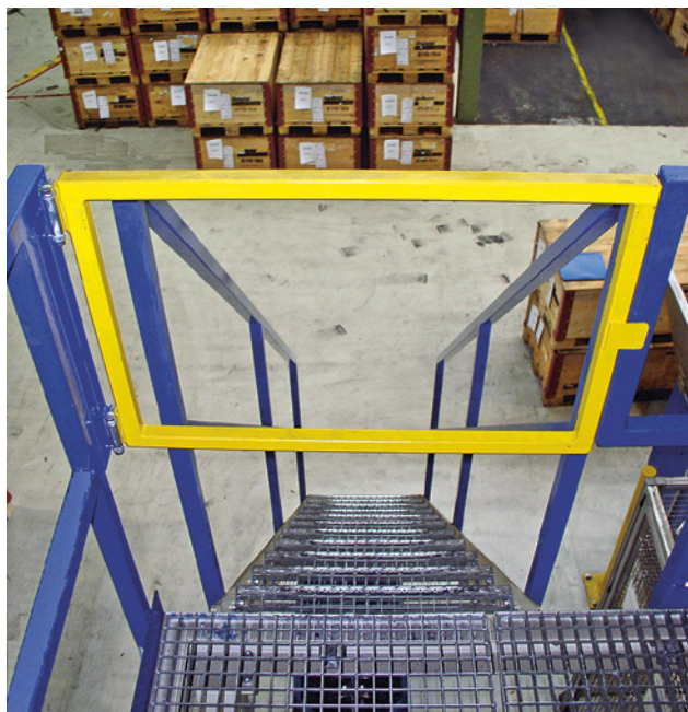
23 Garde-corps en plusieurs parties arrondies. L'espace libre entre les différentes parties du garde-corps est au minimum de 50mm et au maximum de 80mm. Cela évite tout coincement involontaire de la main dans ces espaces ainsi que le risque de chute entre les segments.
