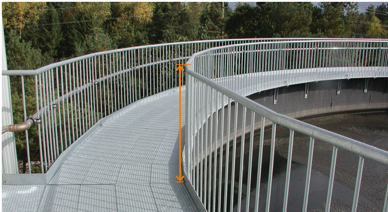
10 La hauteur du garde-corps, du niveau de circulation au bord supérieur de la main courante, est de 1,10m.
