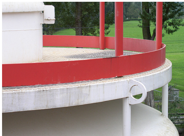
21 L'espace libre entre le sol et la plinthe permet l'écoulement des eaux de pluie et de neige fondue. Il ne doit pas dépasser 12 mm.
