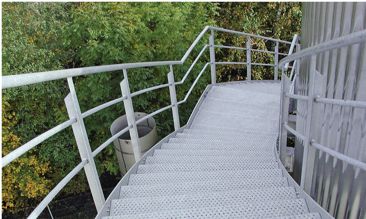
16 Garde-corps d'escalier équipé de deux lisses intermédiaires. L'espace entre la main courante et la lisse supérieure, entre les lisses et entre la lisse inférieure et le limon, ne dépasse pas 500 mm. Le nombre requis de lisses dépend de l'environnement du garde-corps.
