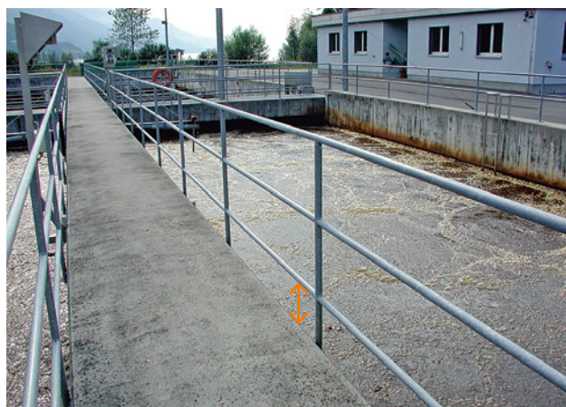
22 Pour des raisons d'exploitation (déneigement), cette passerelle dans une station d'épuration des eaux n'a pas de plinthe. A la place, on a installé une lisse intermédiaire supplémentaire. Dans ce cas, l'espace entre le sol de la passerelle et la lisse inférieure ne doit pas dépasser 300mm.
