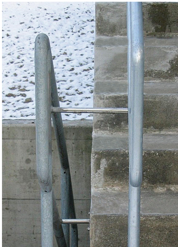
15 Garde-corps avec un espace suffisant entre la main courante et l'escalier. L'extrémité de la main courante est conçue de sorte à éviter tout risque de blessure causée par des arêtes vives ou par la prise des vêtements de l'utilisateur.
