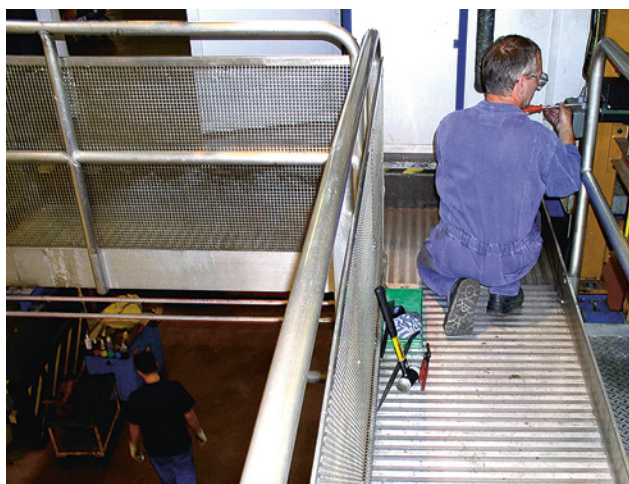
20 Garde-corps le long d'une plateforme de travail équipé de plinthes et d'un remplissage sur toute la surface du côté donnant dans le vide. On évite ainsi que des personnes agenouillées ou des objets ne puissent tomber sur la voie de circulation en contrebas.
