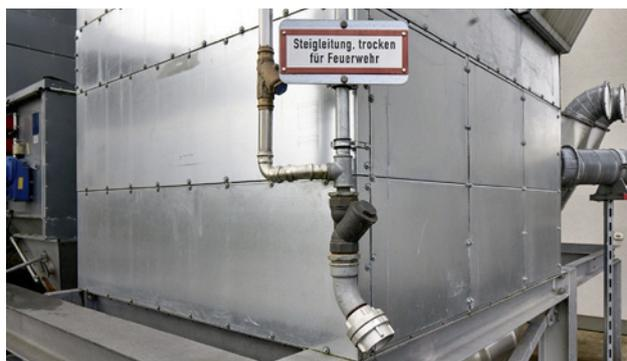
2 Conduit d'extinction à sec avec raccord Storz pour le raccordement avec un tuyau d'incendie (source: Türfabrik Brunegg AG)
