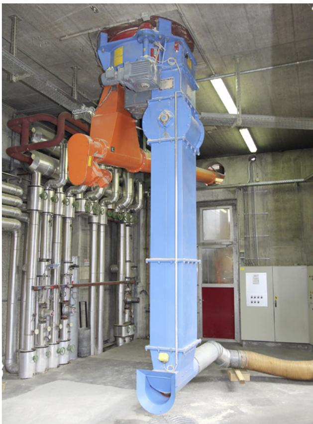
23 Extraction de copeaux par un véhicule aspirateur, durant le fonctionnement, par la deuxième goulotte (bleu) (source: Toma Holz AG)
