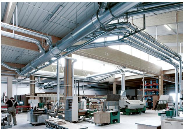
16 Conduits entre les machines à travailler le bois, le système d'extraction et le silo (source: Scheuch Ligno GmbH)
