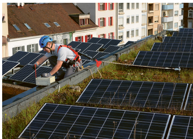
10 Sistema di arresto caduta
