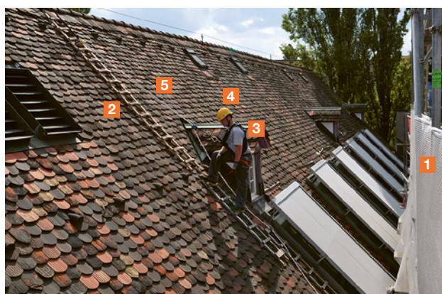
12 Sistema di posizionamento sul luogo di lavoro su un tetto inclinato
