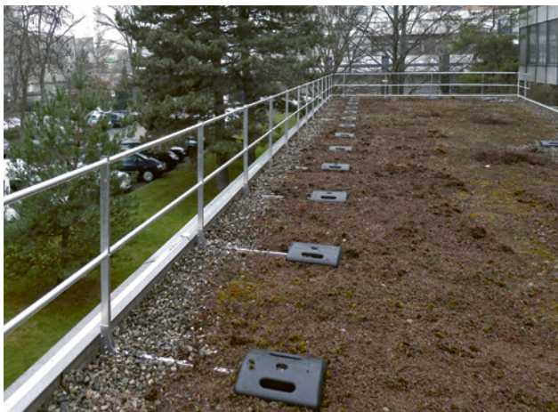
1 Protezione collettiva a bordo tetto per una sicurezza ottimale
