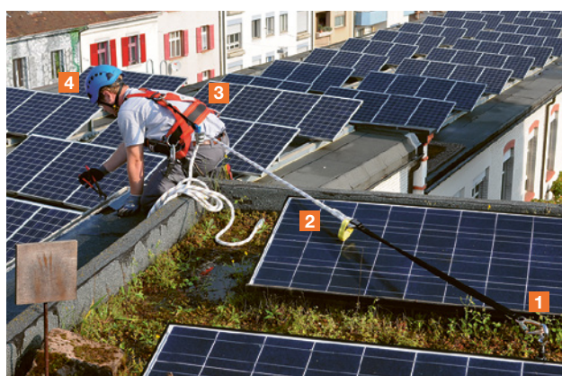
13 Sistema di arresto caduta (ritenuta)
