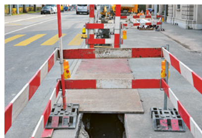
3 Passerelle de chantier.
