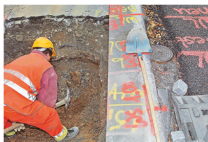
2 Effectuer des sondages dans le terrain.
