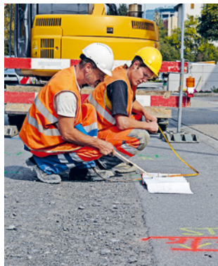
Règle 1 Planifier les travaux.
