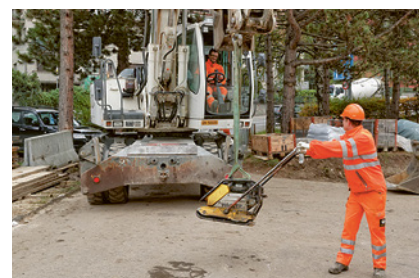
3 Charge correctement transportée au moyen d'une pelleuse sur pneus.
