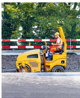
Règle 5 Respecter les consignes d'utilisation des engins de chantier.
