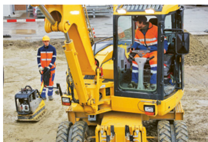
2 Les travailleurs restent hors de la zone dangereuse des engins de chantier.
