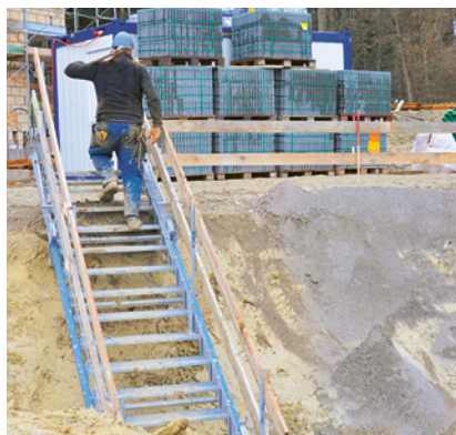
1 Escalier de chantier permettant d'accéder à la fouille.
