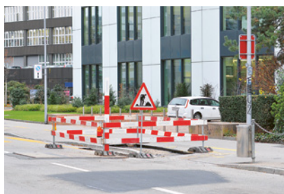
2 La signalisation est aussi obligatoire en cas de travaux de courte durée.
