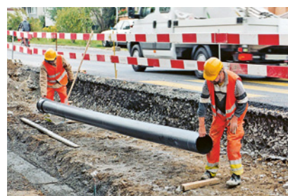
3 Toujours barrer l'accès à la zone de travail.
