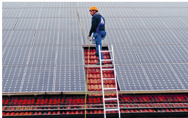
15 Corde lancée par-dessus la toiture, assurée par un antichute mobile
