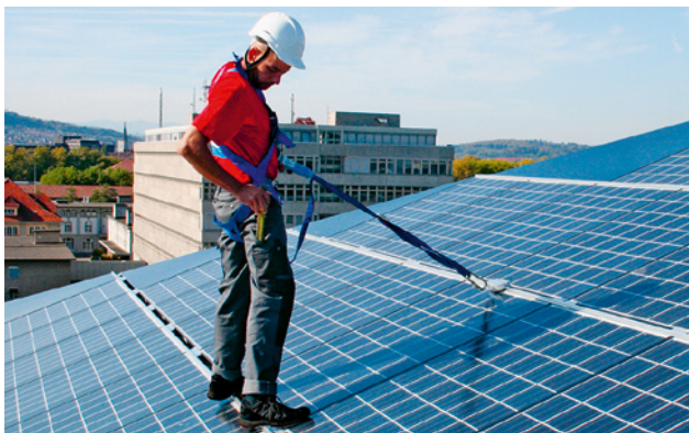
13 Système d'ancrage intégré dans l'installation solaire
