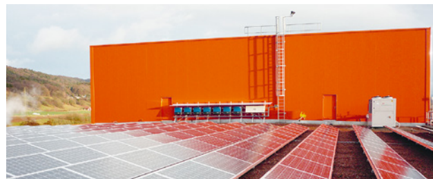
12 Échelle fixe avec protection dorsale
