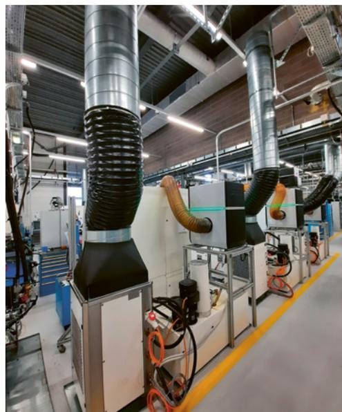
3 Réseau d'aspiration à la source avec filtration et possibilité d'évacuation de l'air à l'extérieur.
