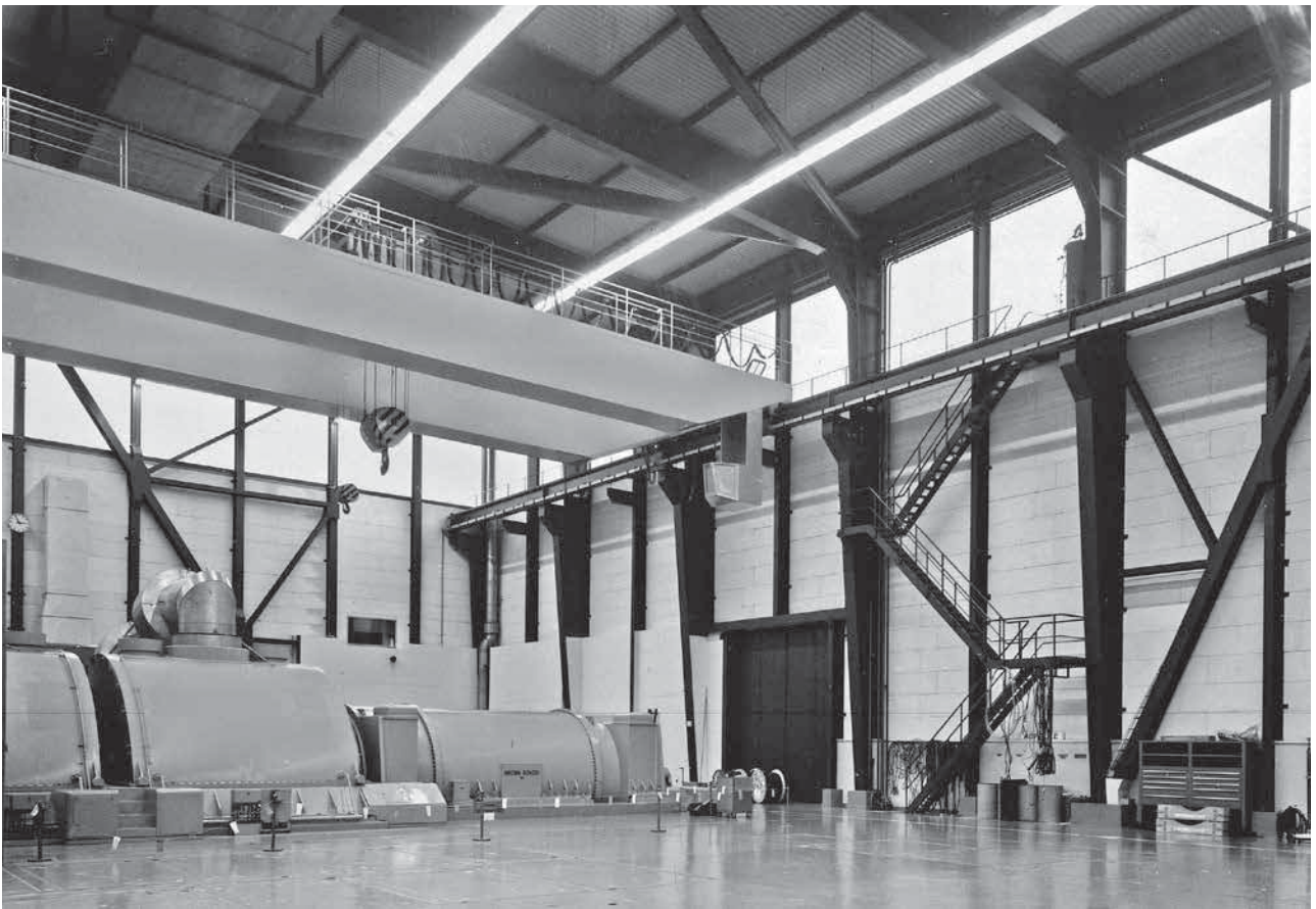
11 Scala di accesso al posto di comando e piattaforme di servizio su un carroponte bitrave.
