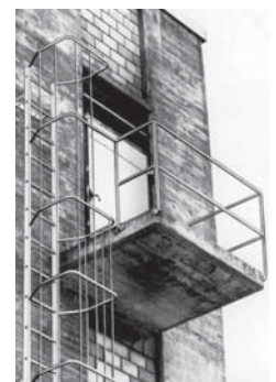
Fig. 4: protection des zones à risque de chute.
