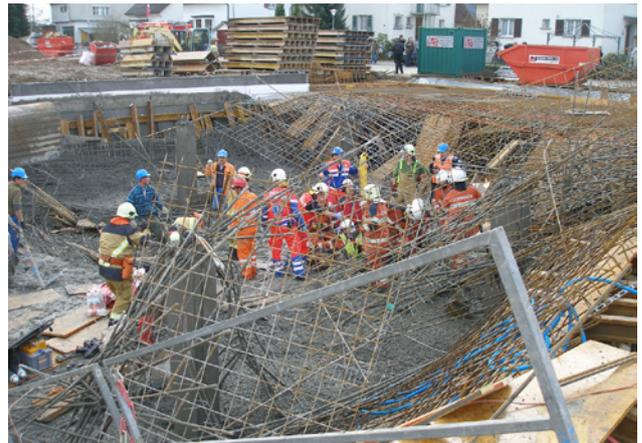
6 Effondrement du coffrage (armature incluse) sous l'effet des forces excentrées.
