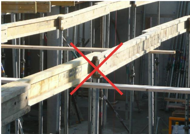
5 Étayage pour éléments en béton préfabriqués: manque de stabilité, étais inclinés, absence de têtes à fourche à la jonction des poutrelles.
