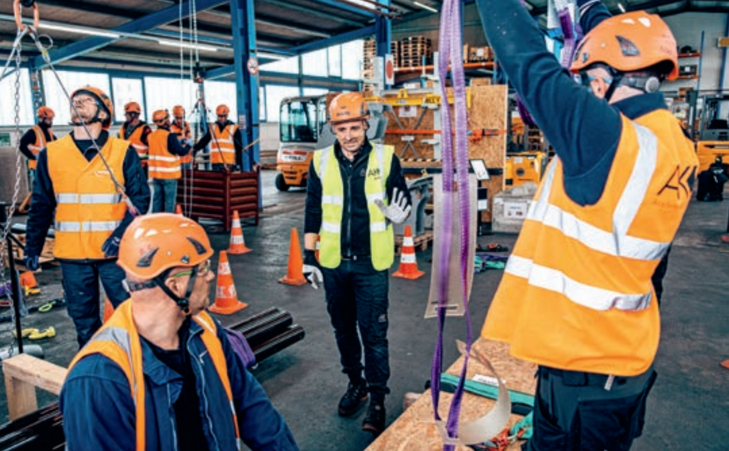
I partecipanti al corso si esercitano nell'uso di diversi metodi e accessori di imbracatura.
