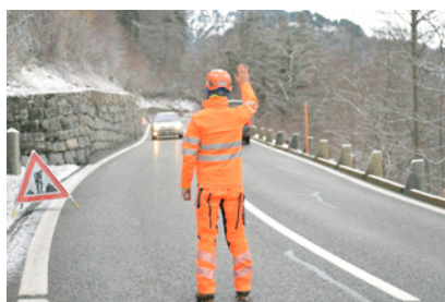
2 Guetteur sur une route d'accès
