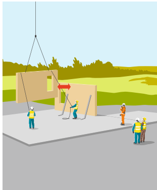
Règle 8 Prendre garde à la charge suspendue.
