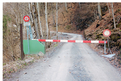
3 Organiser le contrôle et la surveillance des voies d'accès.
