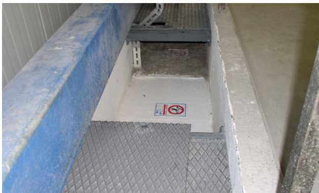
4 Sigillatura antincendio resistente allo sfondamento con lamiera striata calpestabile
