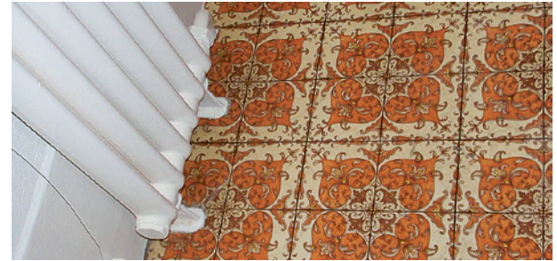
Typisches Muster eines mehrschichtigen asbesthaltigen Bodenbelags
