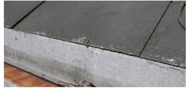
Asbesthaltige Schieferplatten
