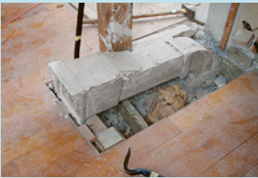
Lüftungskanal aus Asbestzement
