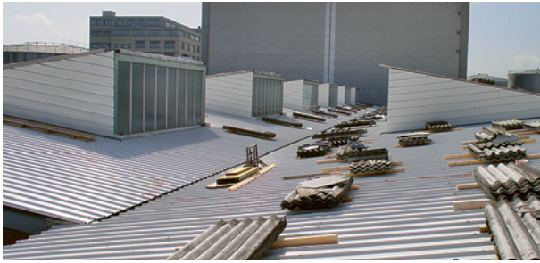
Asbesthaltige Wellplatten
