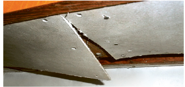
Asbesthaltige Leichtbauplatten als Brandschutz
