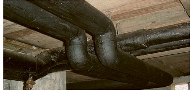
Asbesthaltiger Bitumenanstrich
