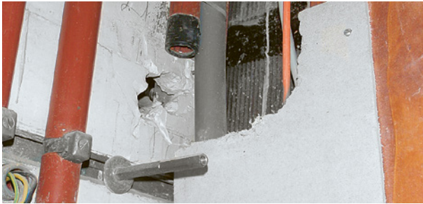
Brandschutzplatte in Steigzone
