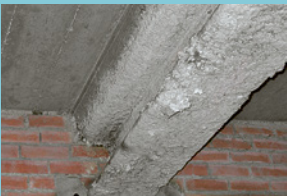
Spritzasbestisolierung
