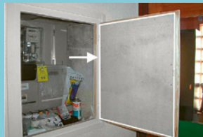
Asbesthaltige Brandschutzplatte
