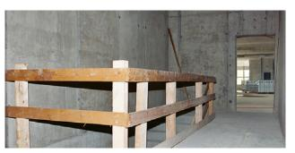
2 Garde-corps périphérique utilisé pour sécuriser une zone à risque de chute
