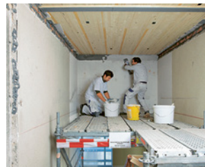
3 Cage d'escaliers avec échafaudage
