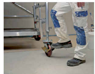
4 Échafaudage roulant arrêté
