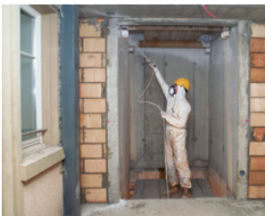
1 Cage d'ascenseur avec plateau d'échafaudage
