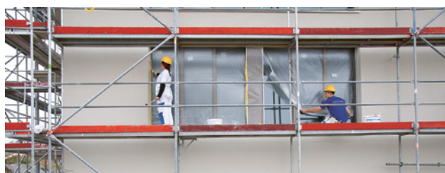
1 Échafaudage de façade
