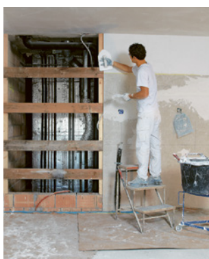
Règle 7 Sécuriser les ouvertures dans les parois.
