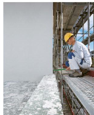
Règle 4 Contrôler les échafaudages chaque jour.
