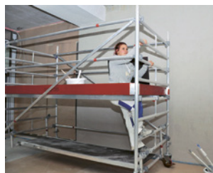
2 Accès interne sur l'échafaudage roulant
