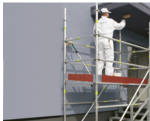
2 Rampe d'accès avec échafaudage
