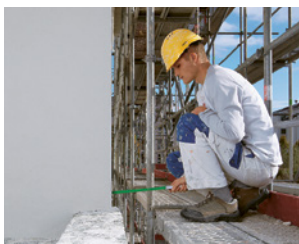
1 Distance de l'échafaudage par rapport à la paroi
