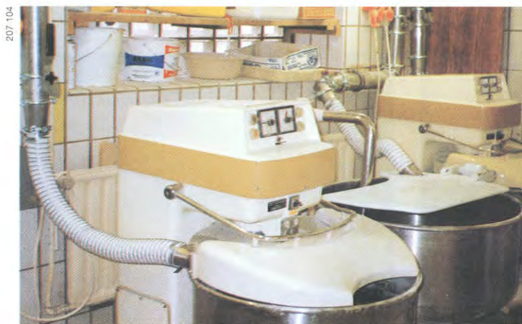
Bild 25 Knetmaschinen mit geschlossenen Verdecken mit Absaugung
