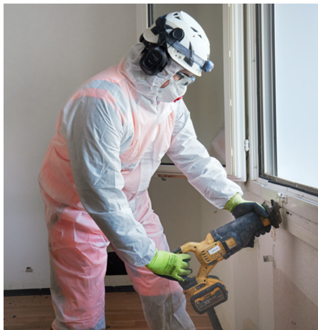
1 Aufschneiden des Fensterrahmens mit einer Fuchsschwanzsäge
