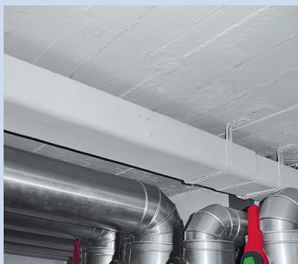
Canalina per cavi in fibrocemento
