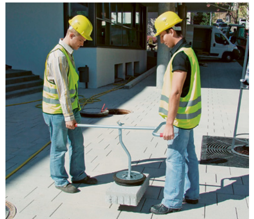
5 Palonnier à ventouse à deux poignées utilisé pour la pose de dalles lisses.
