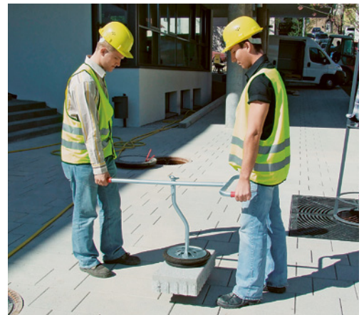
5 Palonnier à ventouse à deux poignées utilisé pour la pose de dalles lisses.
