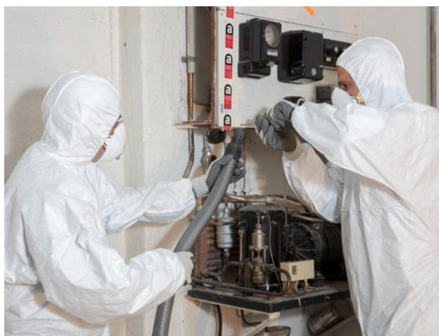
1 Durante i lavori su un'apparecchiatura assiemata di comando, le fibre di amianto rilasciate devono essere aspirate con un aspirapolvere per amianto.
