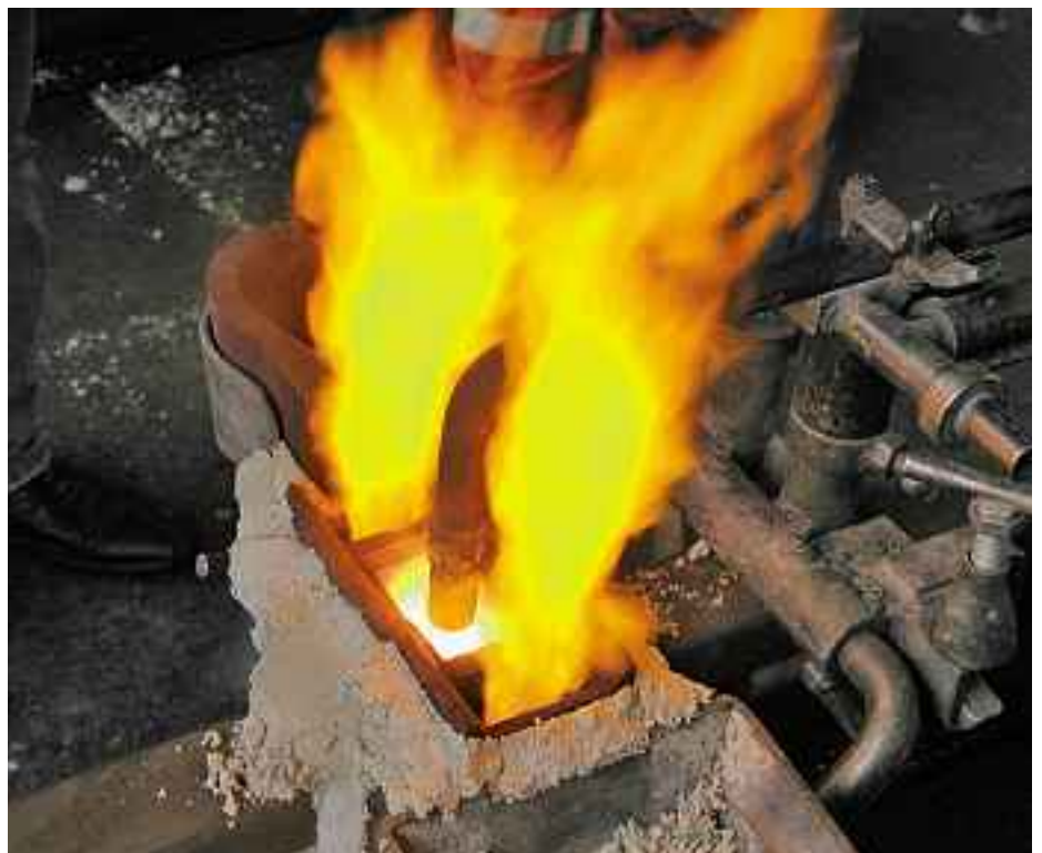
Fig. 1: soudage de rails avec le procédé aluminothermique.
