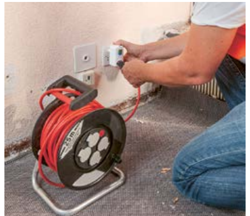
4 Utiliser l'enrouleur électrique avec un dispositif différentiel à courant résiduel mobile (DDR).
