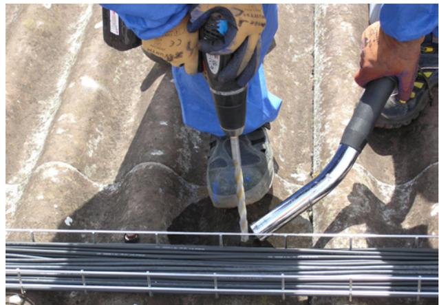
5 Faserzement befeuchten, Löcher mit niedriger Drehzahl bohren und Quellenabsaugung einsetzen.
