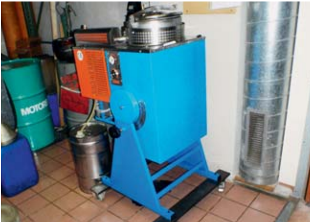
29 Installation de distillation pour liquides inflammables
