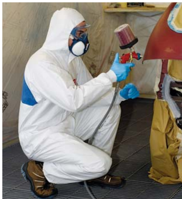
14 Pulvérisation de peinture à base aqueuse. Protection respiratoire au moyen d'un demi-masque filtrant à charbon actif.
