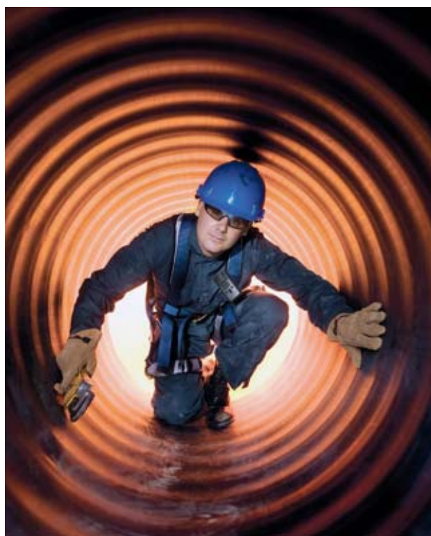
28 Utilisation d'un « détecteur de gaz » en espace confiné
