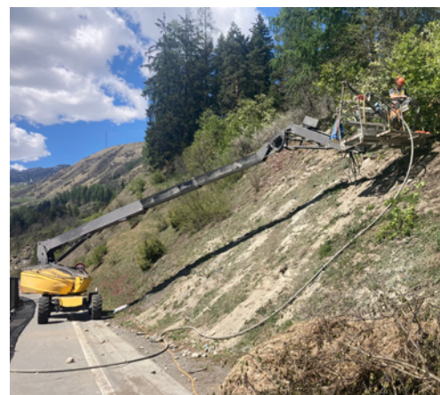
5 Plateforme élévatrice PEMP permettant d'accéder en sécurité au train de tiges
