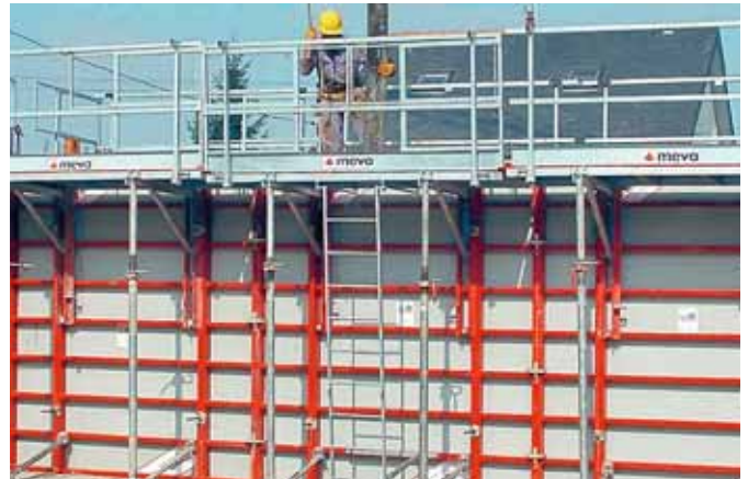
02 // Richtig: So sieht ein korrekt erstelltes Betoniergerüst mit einem dreiteiligen Seitenschutz aus. // Bild: zvg
