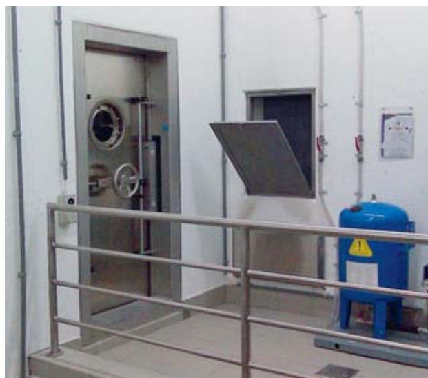
6 e 7 I locali con elevata concentrazione di radon vengono chiusi ermeticamente.
