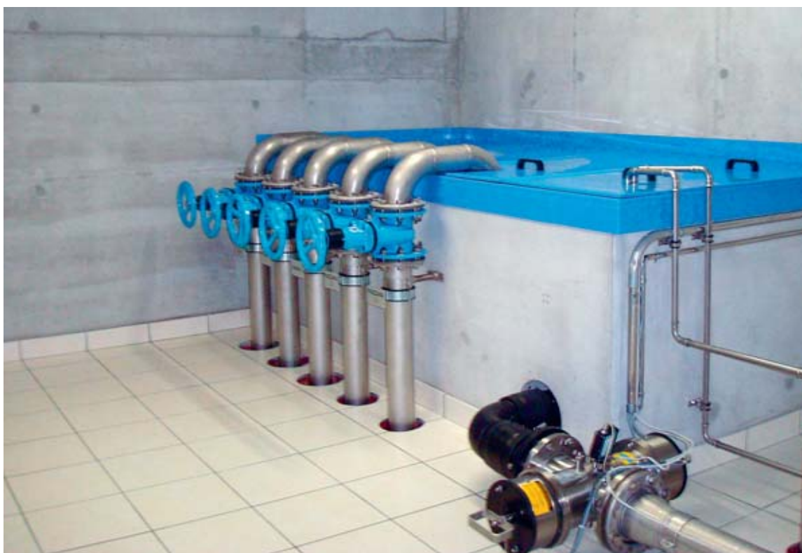
4 e 5 Il radon viene fatto uscire dall'acqua tramite degassazione.
