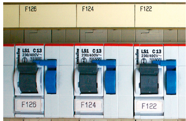
11 Leitungsschutzschalter
