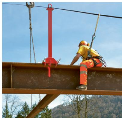
2 Temporäres Pfostensystem für eine durchlaufende Anschlagvorrichtung
