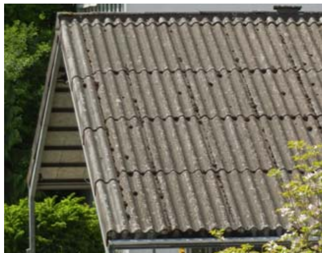
1 Plaques ondulées en fibrociment amianté
