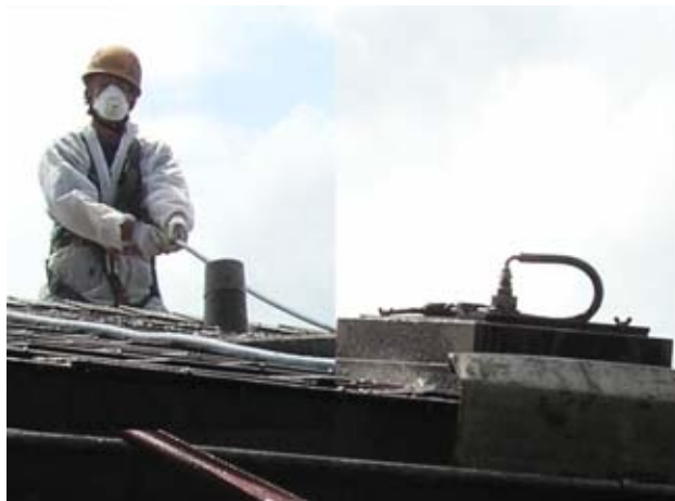
4 Système de nettoyage de surfaces amiantées avec circulation d'eau régulée
