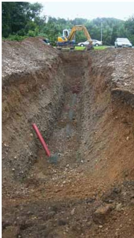
**01** // La fouille où s'est produit l'accident avait une profondeur supérieure à 1,5 m et aurait donc dû être sécurisée avec des mesures appropriées (talutage, étagage) conformément à l'ordonnance sur les travaux de construction. // Photo: Suva
