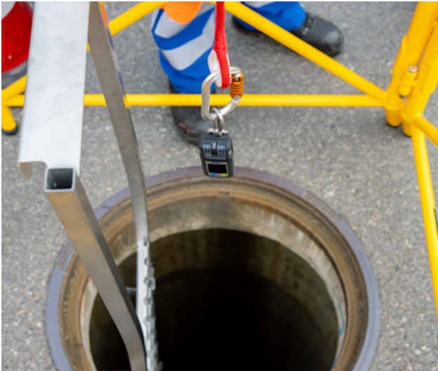
9 Eine Freimessung muss durchgeführt werden, wenn keine künstliche Lüftung vorhanden ist.
