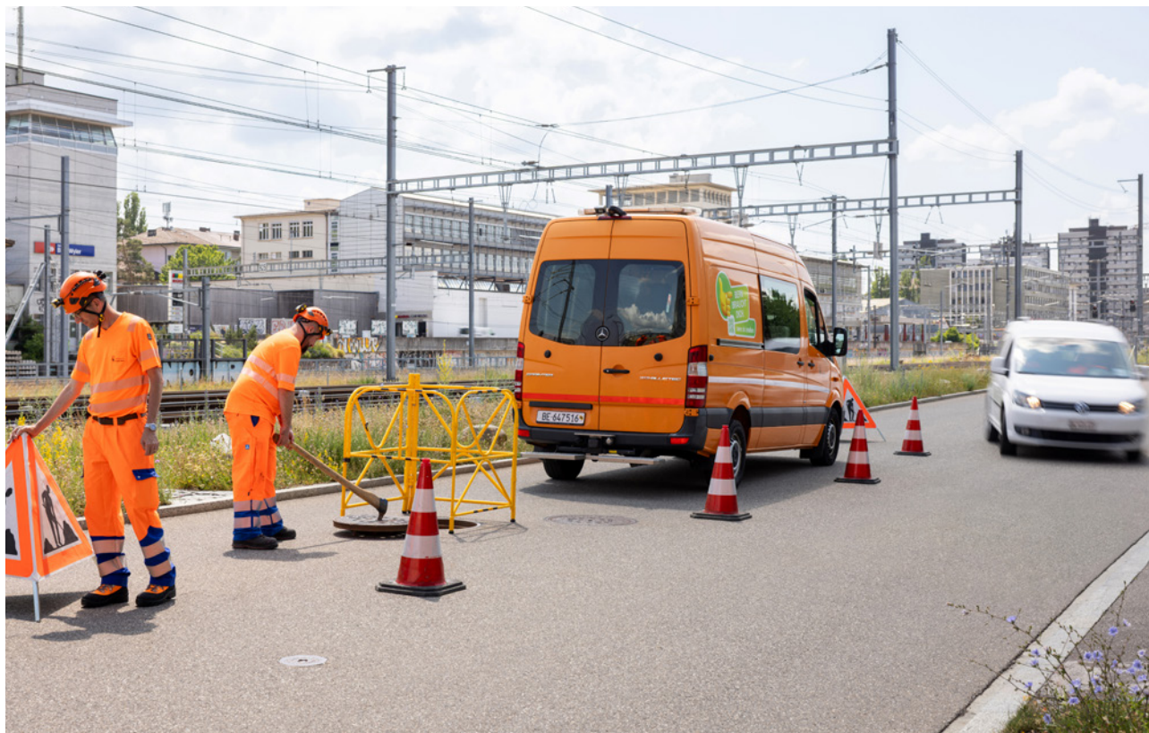
14 Den Arbeitsbereich gegenüber dem Verkehr absichern.
