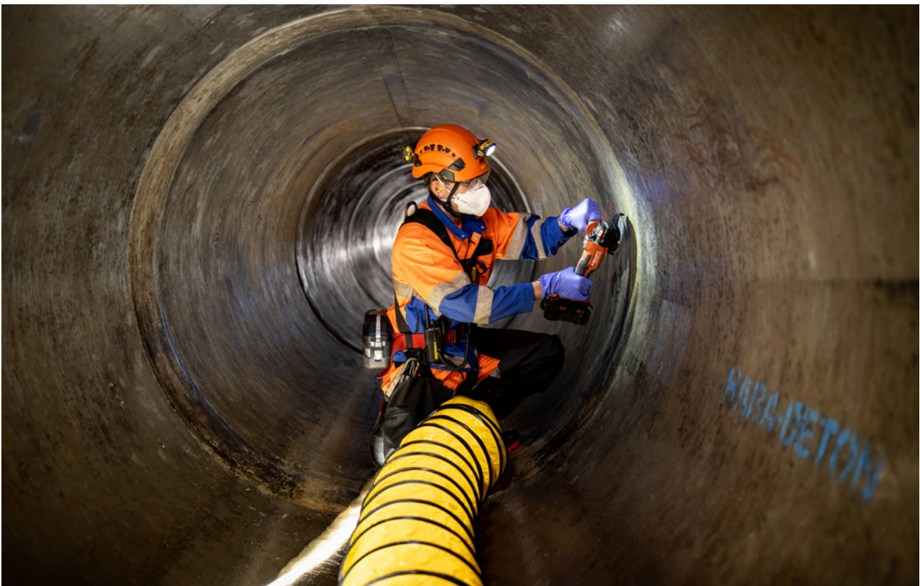
11 Schleifarbeiten mit der notwendigen persönlichen Schutzausrüstung.
