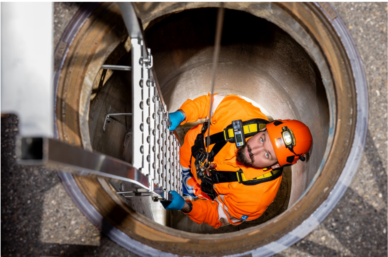
4 Fest installierte Leitern sind stabil mit der Baukonstruktion verbunden und können nicht verrutschen. Dies reduziert das Risiko von Abstürzen beim Ein- und Aussteigen deutlich.
