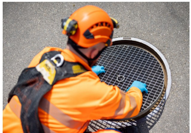
3 Ein Gitterdeckel verhindert Abstürze
