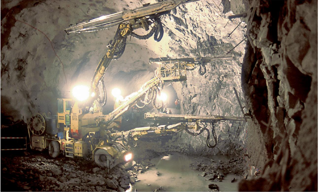
1 Postes de travail exposant fortement au bruit sur un chantier de creusement d'un tunnel
