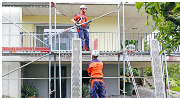
4 Montage avec des EPI antichute
