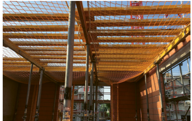
4 Konventionelles Schalen mit kollektiver und nachweislich geprüfter Sicherheitseinrichtung (Auffangnetze).
