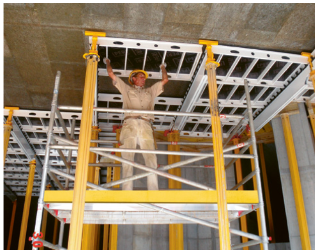
1 Zeitgemässes System: Schalen und Ausschalen von unten.
