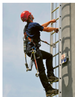
2 Un dispositif antichute mobile est nécessaire à partir de 3 m de hauteur de chute.
