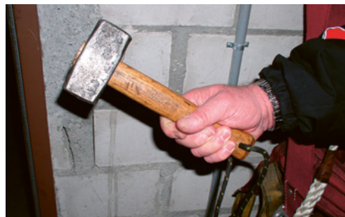
8 Pour éviter la chute d'objets, les outils sont fixés au harnais au moyen d'une cordelette.
