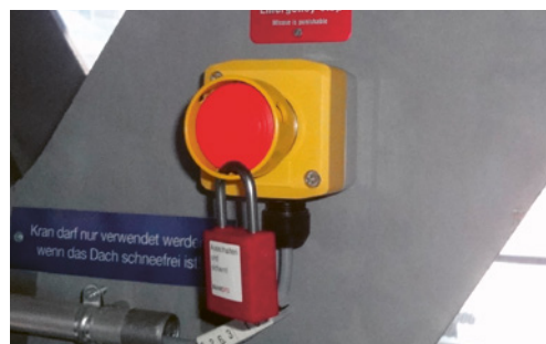
3 Dispositif d'arrêt d'urgence situé à l'accès aux zones dangereuses.
