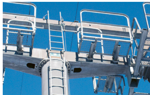
1 Plateforme équipée de garde-corps.
