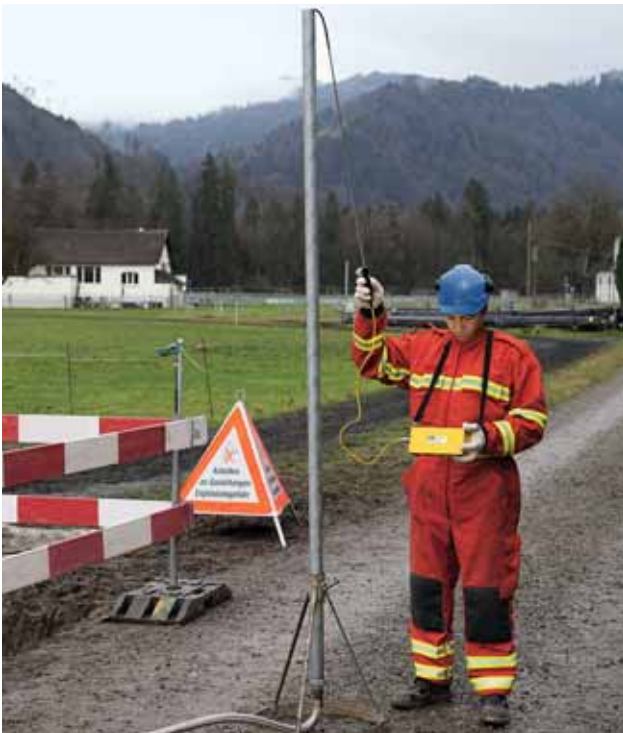
Figura 24 Scarico del gas naturale
