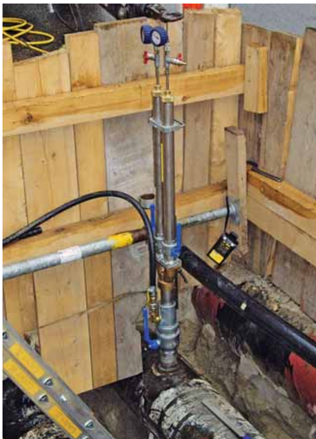
Figura 26 Misurazione del gas nell'area di lavoro
