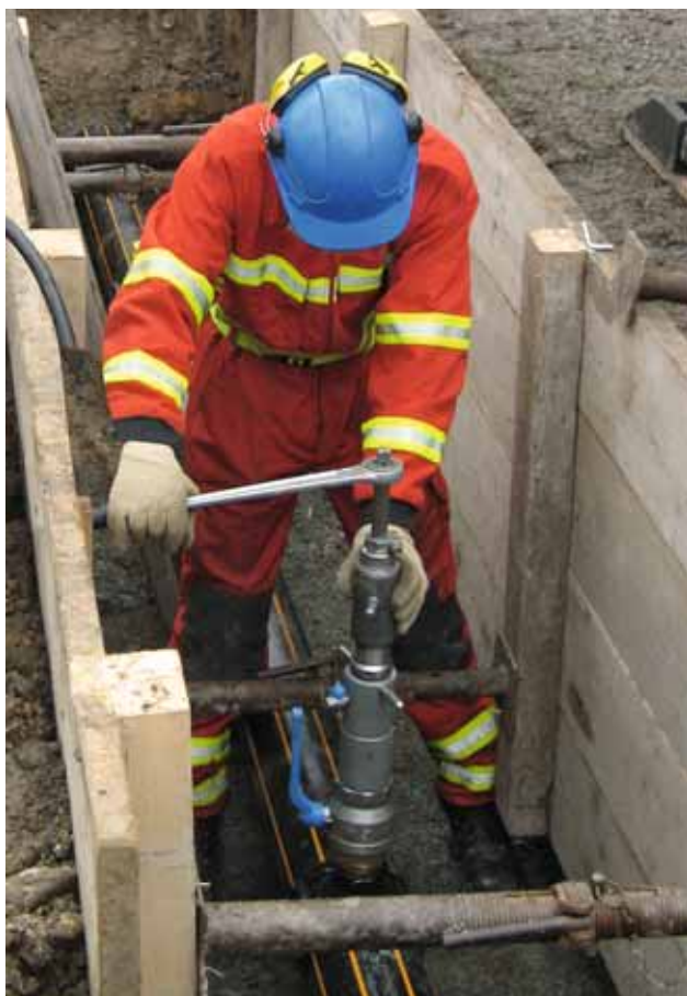
Figura 1 Foratura con dispositivo senza fuoriuscita di gas
