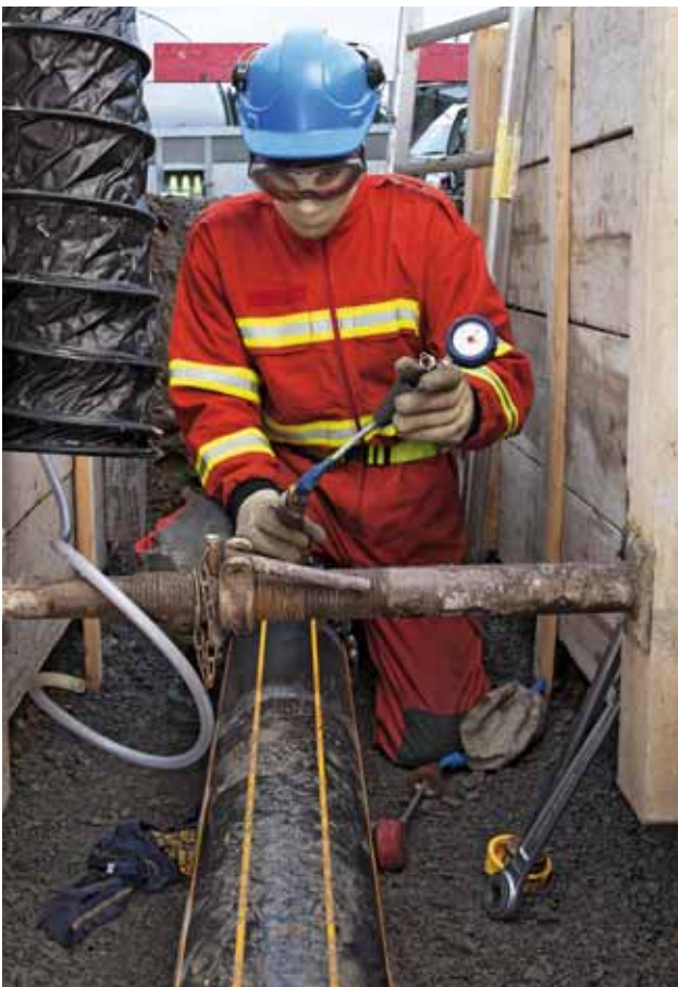
Figura 3 Posizionamento di un pallone otturatore manuale
