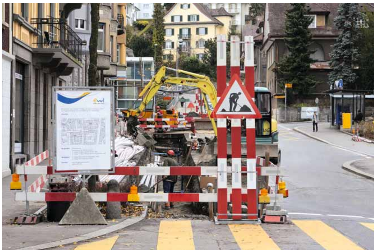
Figura 22 Cantiere chiuso al traffico
