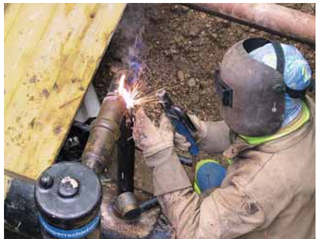
Figura 5 Saldatura sotto pressione del gas
