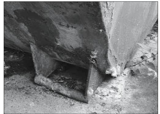
Bild 4: Angerissene, defekte Kipplager müssen ausgewechselt oder repariert werden.
