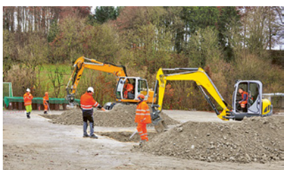
1 Formazione per la guida delle macchine edili
