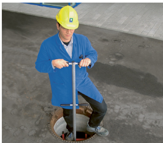
1 Einstieg in einen Schacht mit Hilfe einer Haltevorrichtung
