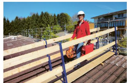
3 Surfaces de toiture non résistantes à la rupture: utiliser des passerelles.
