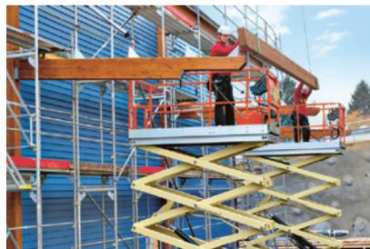
2 Plateforme élévatrice pour le montage d'éléments porteurs
