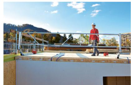
3 Garde-corps mobile pour zone à risque de chute temporaire au bord du toit
