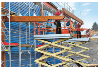
2 Plateforme élévatrice pour le montage d'éléments porteurs
