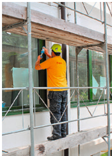
2 Ponteggio di facciata come protezione anticaduta
