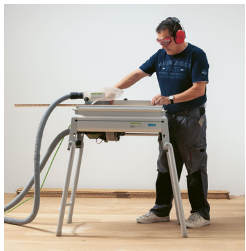
3 Sicheres Arbeiten an der Kleintischkreissäge mit Schutzhaube und angeschlossenem Staubsauger
