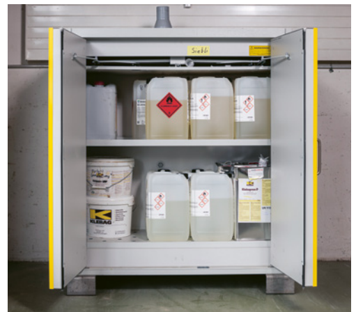
4 Korrekte Lagerung von lösemittelhaltigen Produkten. Den Einsatz lösemittelfreier Produkte regelmässig prüfen lassen.
