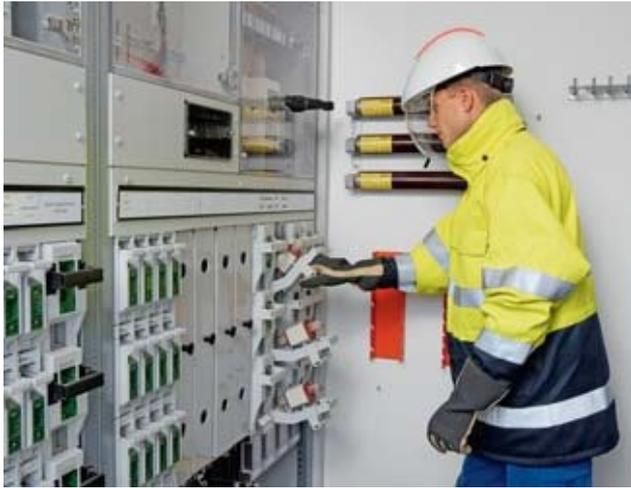
1. Déclencher et ouvrir les sectionneurs de toutes parts.
