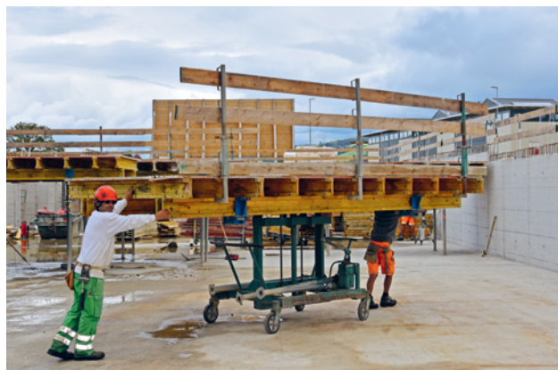
6 Modulo con protezione collettiva già montata (protezione laterale a tre elementi) durante il trasporto
