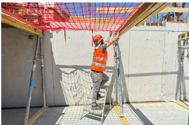
4 Montaggio di una rete di sicurezza con l'ausilio di una scala
