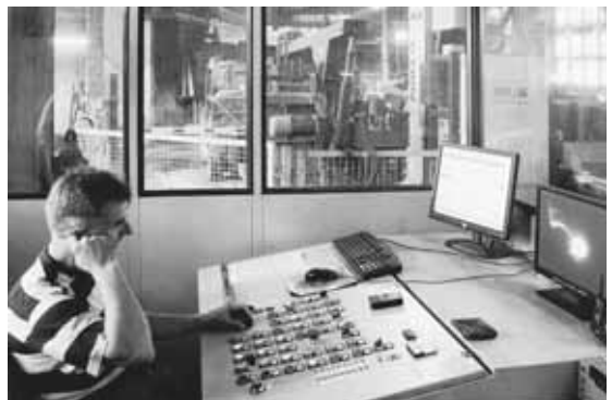
Figure 29: Cabine de commande dans une frouderie.
