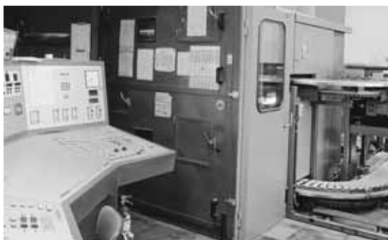
Figure 24: Vue partielle de l'enceinte de la plieuse d'une presse rotative: à gauche, le pupitre de commande, à droite, le convoyeur sur lequel les journaux pliés quittent l'enceinte.
