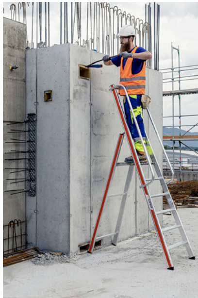
20 Lavori su una parete di calcestruzzo
