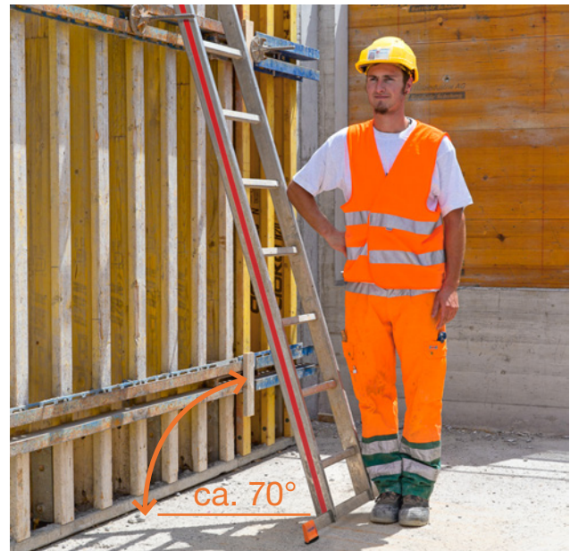
35 Prova del gomito per verificare la corretta inclinazione
