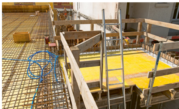
32 Passaggio messo in sicurezza: la scala sporge di almeno un metro dal bordo del piano superiore
