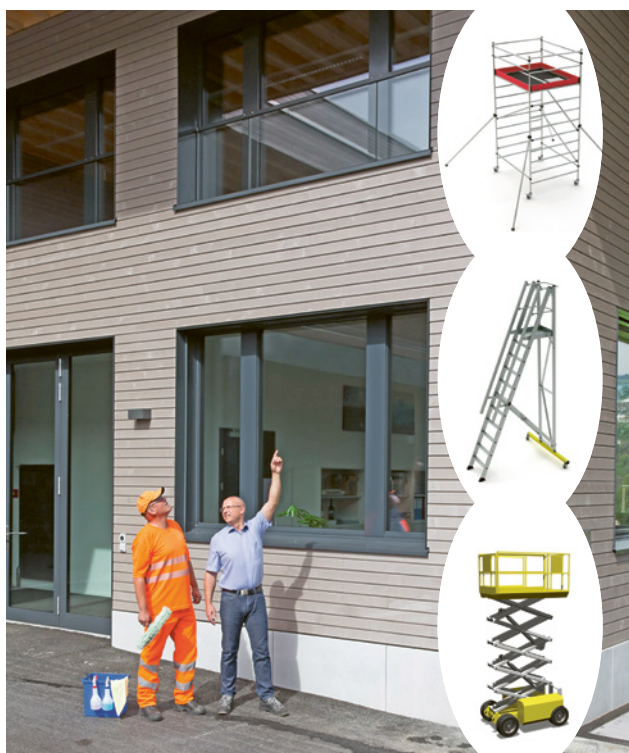
1 Prima di iniziare i lavori è importante decidere quale attrezzatura è più adeguata alla situazione
