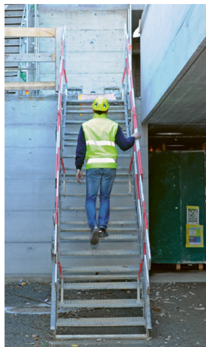
9 Scala a gradini da cantiere
