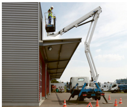
7 Piattaforma di lavoro elevabile a sbraccio
