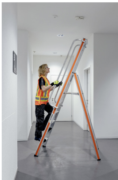
23 Lavori di manutenzione di uno stabile
