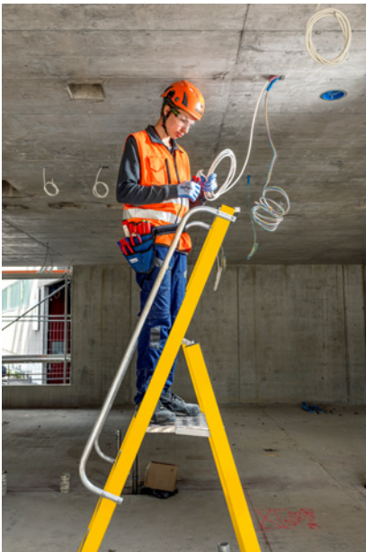
19 Lavori di tecnica della costruzione
