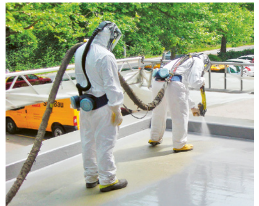
6 Pour chaque travail, les protections individuelles nécessaires doivent être mises à disposition et portées.
