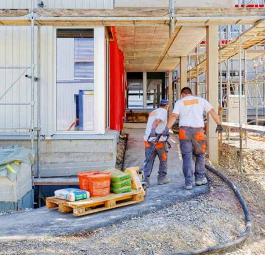
Accès carrossables malgré la différence de niveau du terrain
