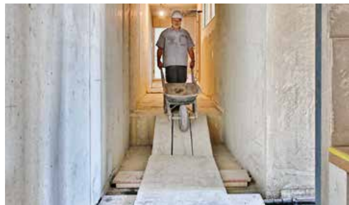
Accès carrossables malgré des différences de niveau dans le bâtiment
