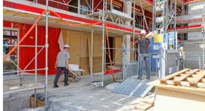
Accès carrossables à la nacelle de façade et au bâtiment
